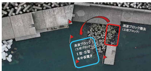
▲ 赤部分□の消波ブロックを青部分□に仮置きします。後に元の部分に戻します。
